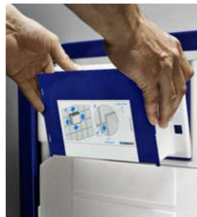
De springkoker klemt u eenvoudig zonder schroeven op zijn plaats
