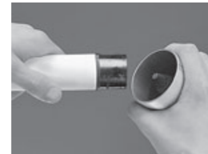
Afb. 8.0-45: Uit-en inwendig ontbramen met handontbramer
