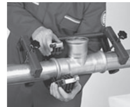
Afb. 8.0-14: De persketting aanbrengen
