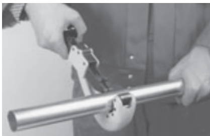
Afb. 10.0-5: Op maat zagen met een buizensnijder
