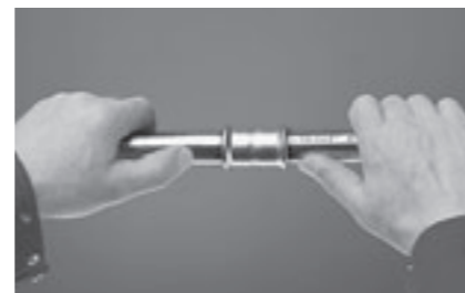
Afb. 8.0-12: De systeemleiding in de persfitting schuiven
