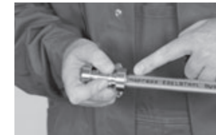
Afb. 10.0-13: De systeemleiding in de persfitting schuiven
