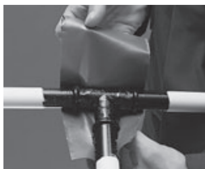
Afb. 9.0-2: De corrosiebeschermende tape aanbrengen
