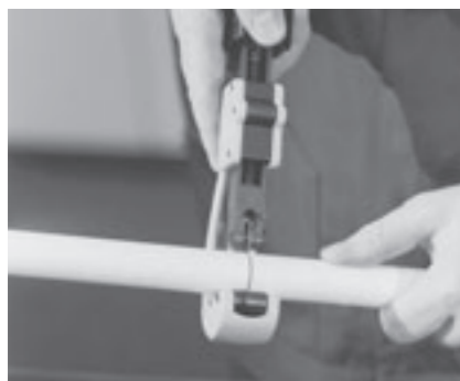
Afb. 8.0-26: Op maat snijden met buizensnijder
