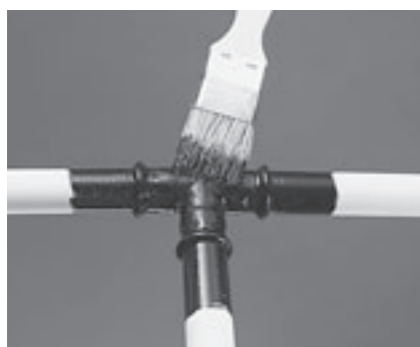
Afb. 9.0-1: Verven met primer
