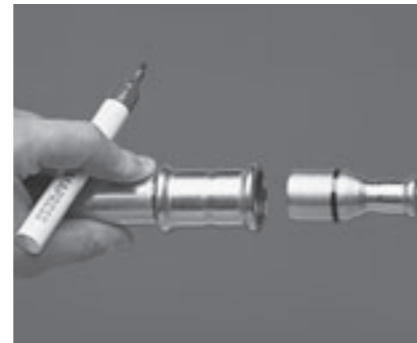
Afb. 8.0-38: Persfitting met inschuifuiteinde en markering van de insteekdiepte 'e'
