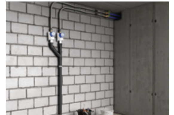
↑ VOORBEELD: VERBINDINGSLEIDINGEN NAAR ANDERE GEBOUWDELEN
