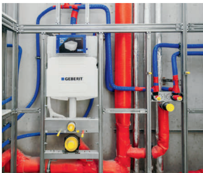
↑ GIS, geïntroduceerd in 1993, is de oplos- sing van Geberit voor sanitaire voorwan- den in droogbouw. Ideaal voor het prefa- briceren van complete sanitaire wanden, wat de montage versnelt.
