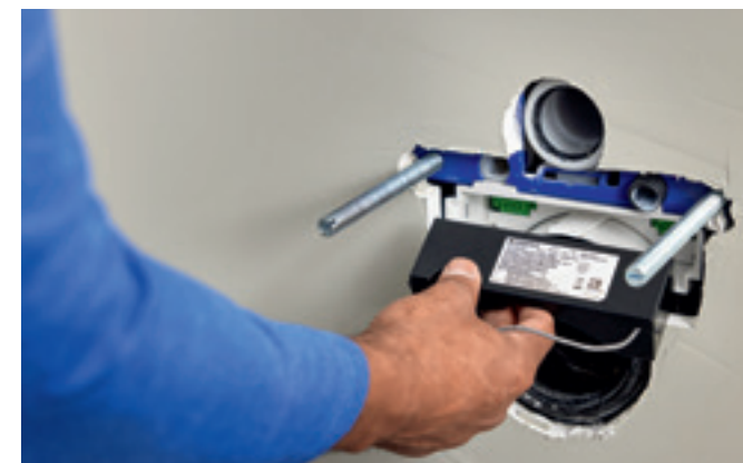
Installatie van de GEBUS-converter voor wc-besturingen met geïntegreerd voedingsapparaat
