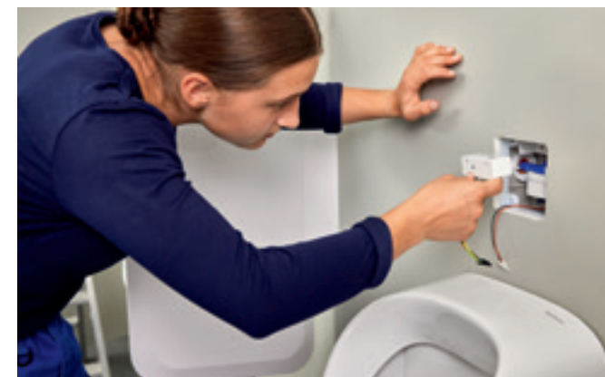
Installatie van de GEBUS-converter voor inbouw urinoirsturingen en wastafelkranen
