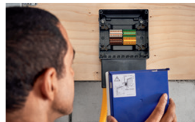
Installatie van de Geberit Gateway
